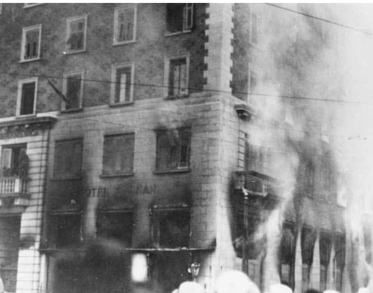
L'hotel Balkan in fiamme, il tramonto di un mito.
